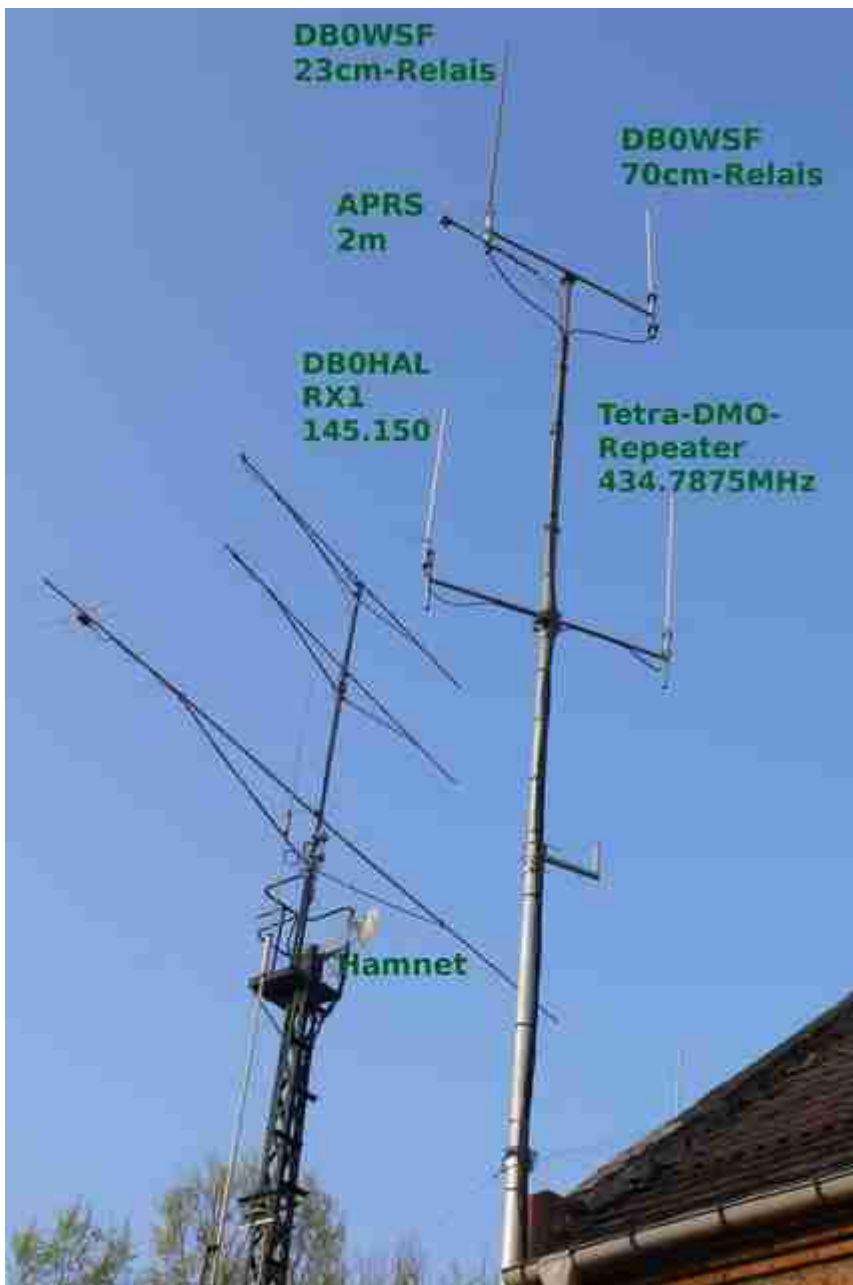
Antennenanordnung bei DBWSF
