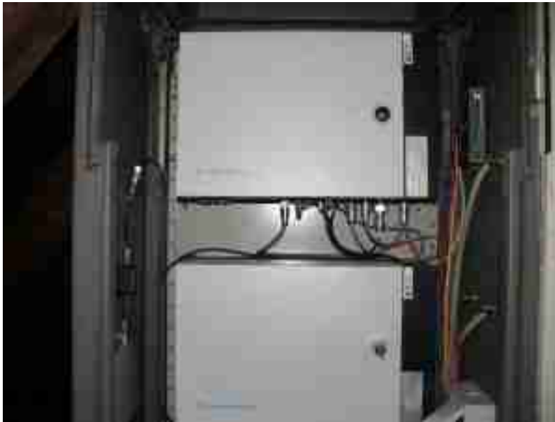
Bild 6: 2m und 70cm Relaisstationen MC Compact (Motorola)
