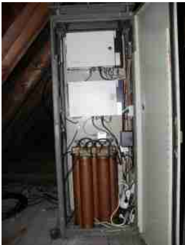
Bild 5: Der Relaisschrank (2m/70cm ohne 23cm)
